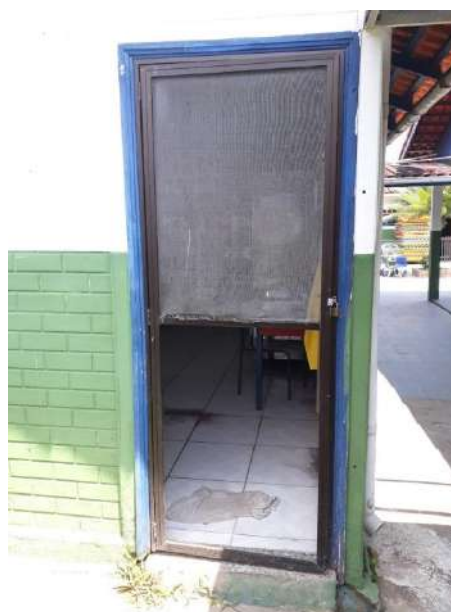
Porta da cozinha sem parte da tela milimetrada.
