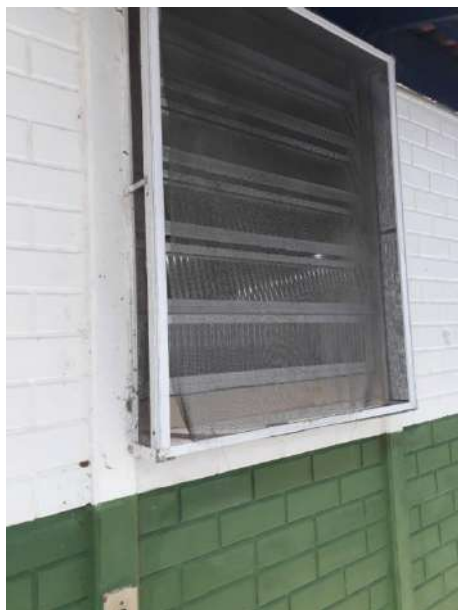
Janelas da cozinha com problemas nas telas milimetradas.
