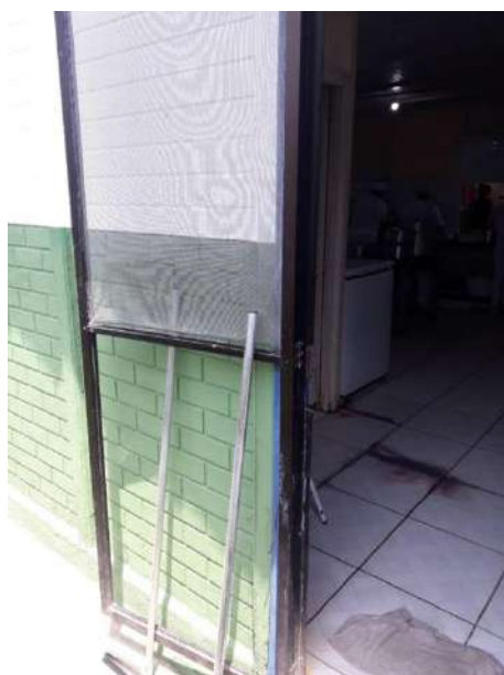
Porta da cozinha sem parte da tela milimetrada.
