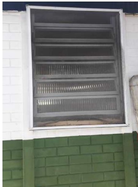
Janelas da cozinha com problemas nas telas milimetradas.
