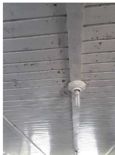
Mofo no teto de uma das salas do maternal.
