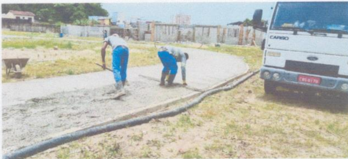
FOTO 15: Concretagem da ciclovia.
