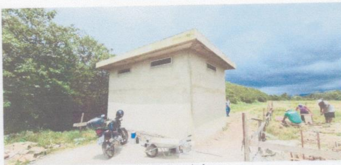
FOTO 08: Casa de força.
