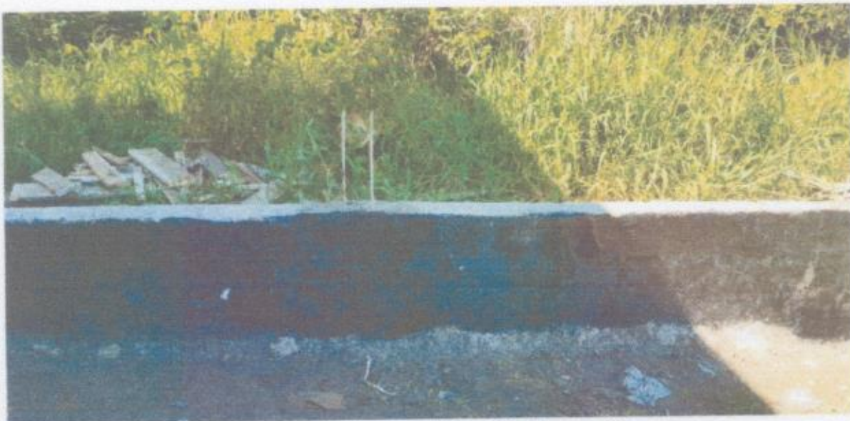
FOTO 05: Impermeabilização da mureta.
