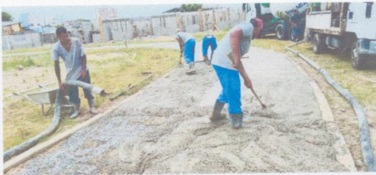
FOTO 14: Concretagem da ciclovía.
