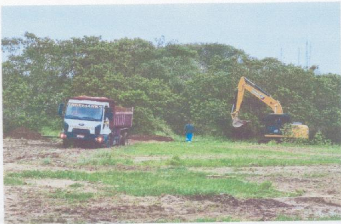
FOTO 11: Execução de aterro.
