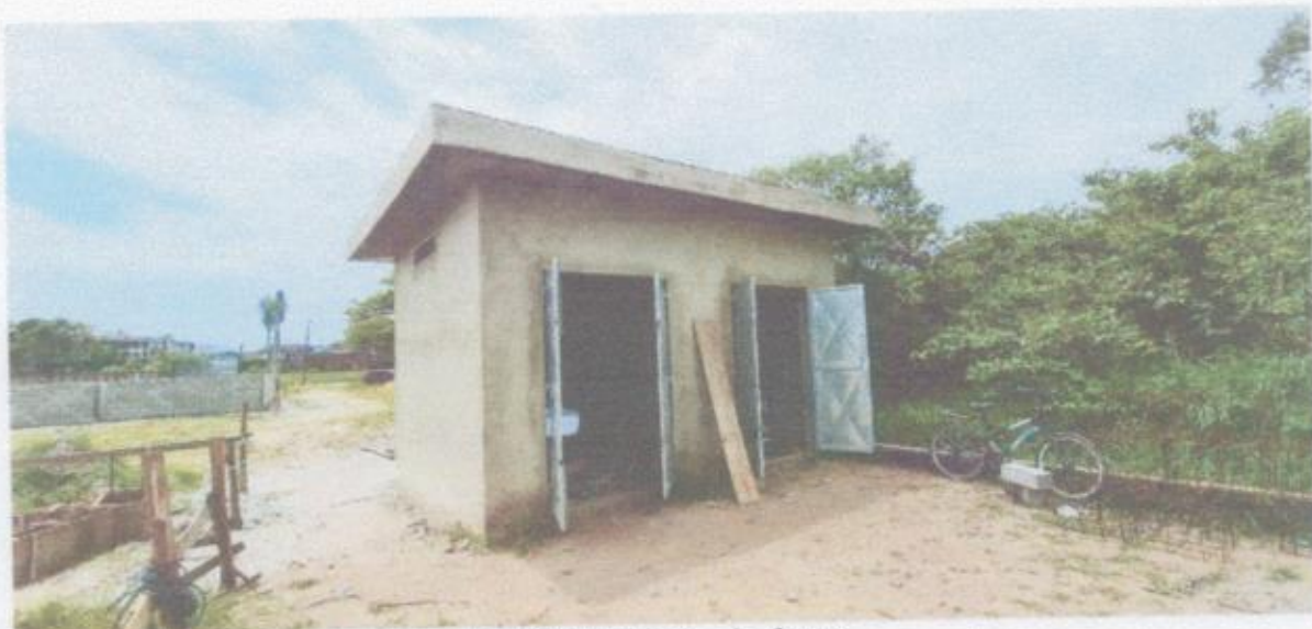
FOTO 07: Casa de força.
