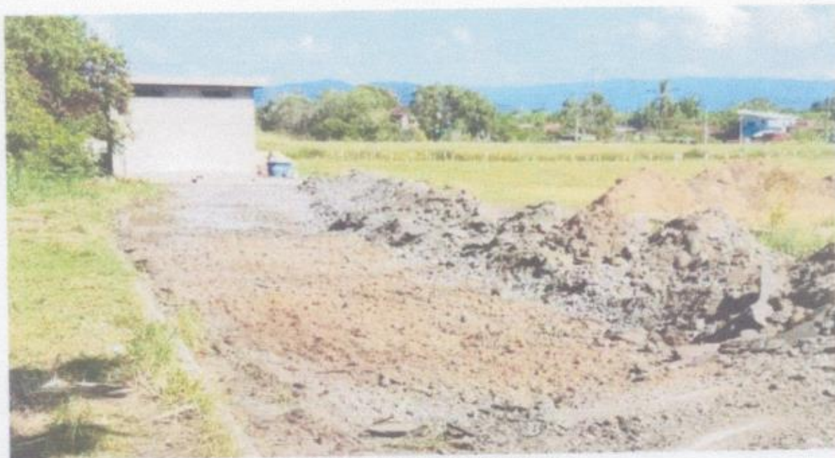
FOTO 06: Limpeza do terreno.
