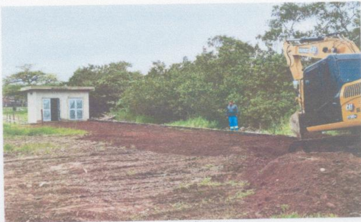
FOTO 09: Execução de aterro.
