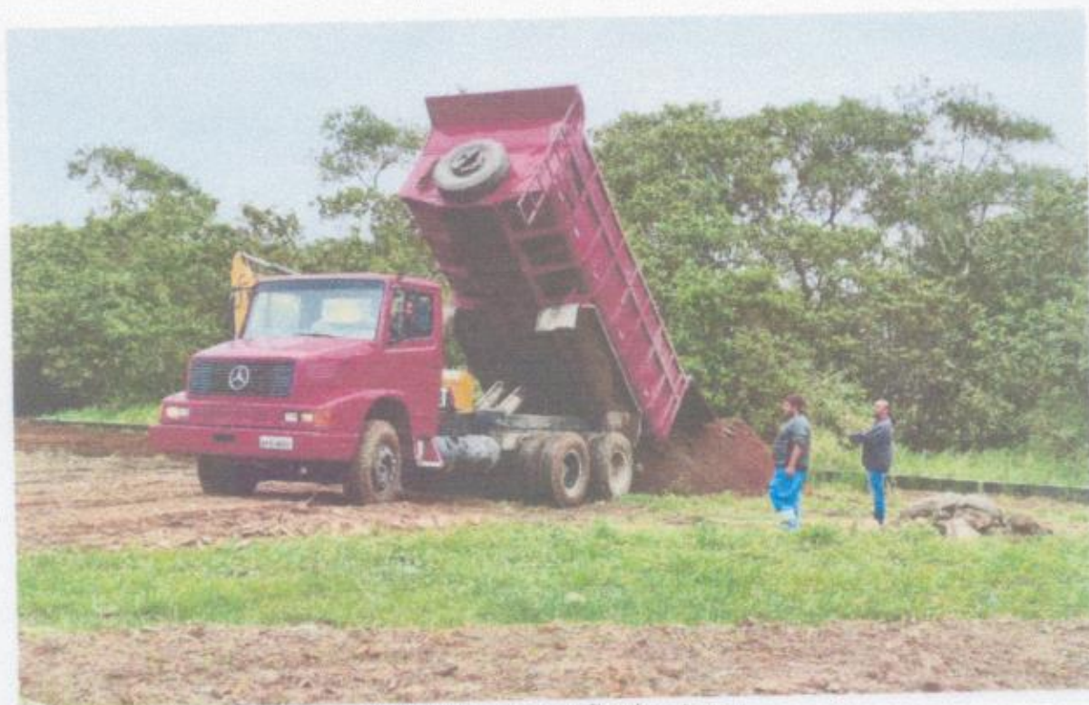
FOTO 10: Execução de aterro.
