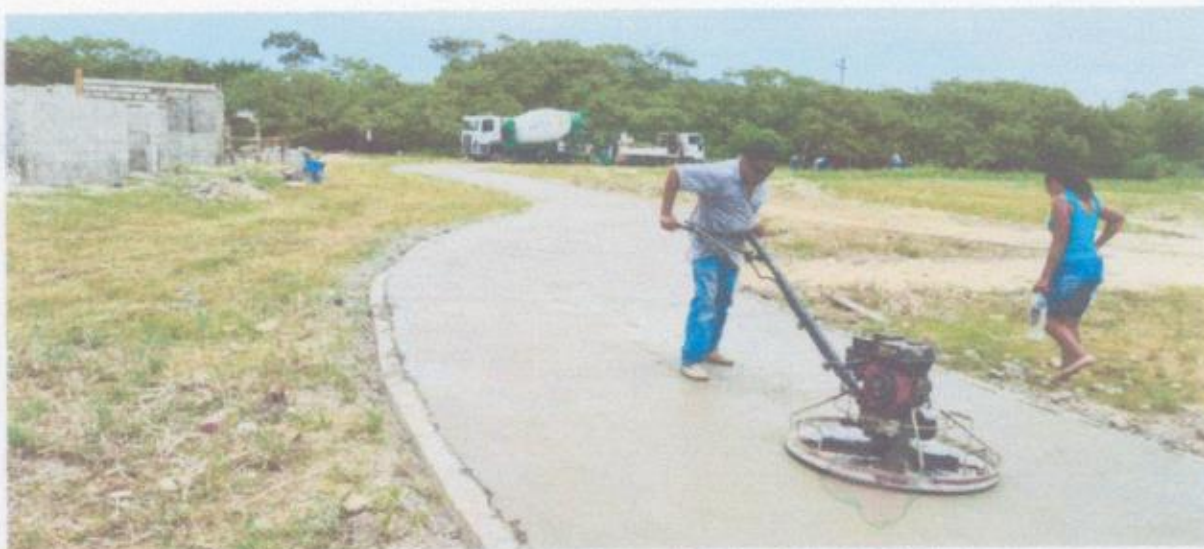
FOTO 16: Acabamento com alisadora de concreto.
