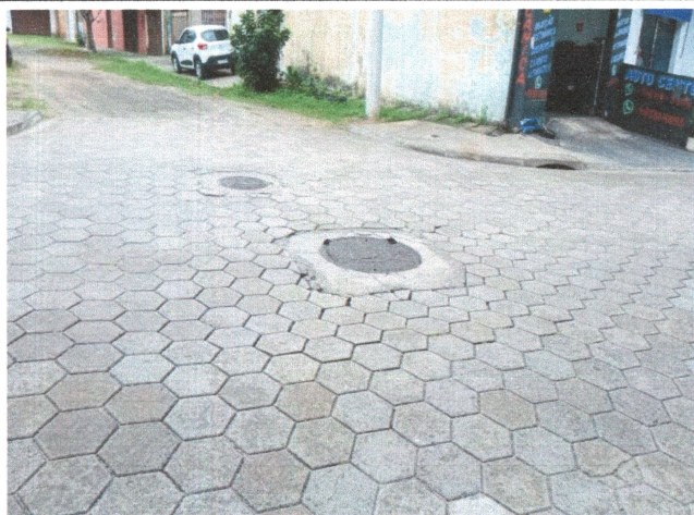
Foto Nº 1 SOLAPAMENTO EM VOLTA DO PV RUA PEDRO AMÉRICO/RUA FELICIO LIMA.
