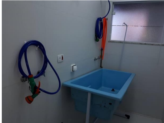
Figura 5: Sala de Descontaminação
