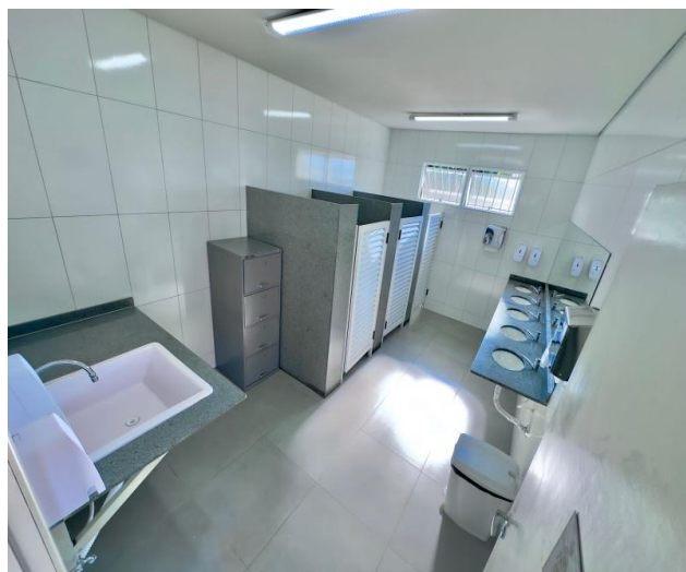
Anexo 3 – Parte Interna Banheiro Feminino com trocador.
